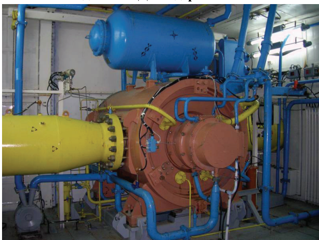
Рис. 8. Компрессор НЦ-16 с ЭМП для газопровода «Ямал-Европа» на КС «Слонимская»
