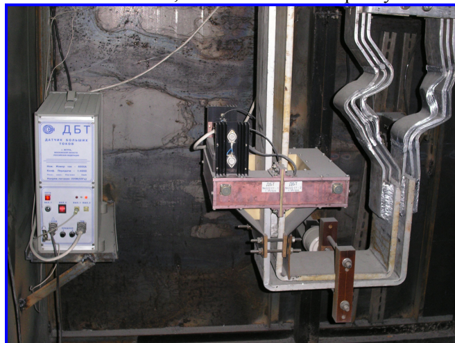
Рис. 5. Датчик больших токов ДБТ, смонтированный на шинопроводе электролизера алюминия
