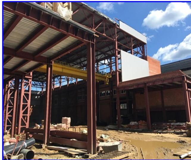
Рис. 4. Испытательный комплекс для испытания насосов до 7000 м 3 /ч
