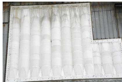
**Рис. 6. Передающее радиопрозрачное укрытие полигональной радиолокационной станции**
