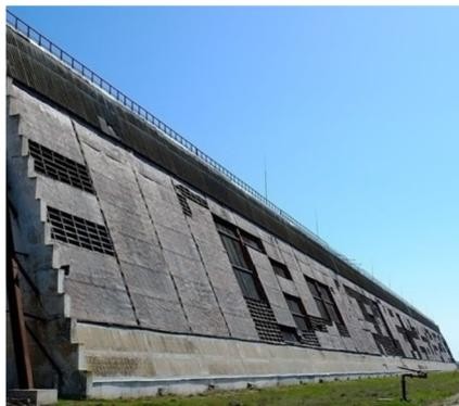
Рис. 1. Радиопрозрачное укрытие радиолокационной станции дальнего обнаружения
