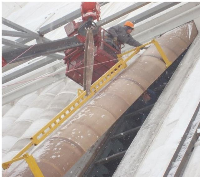
**Рис. 14. Монтаж опытного образца секции радиопрозрачного укрытия в состав радиопрозрачного укрытия передающей фазированной антенной решетки многофункциональной радиолокационной станции**
