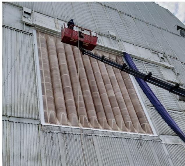
**Рис. 15. Проверка качества монтажа радиопрозрачного укрытия в части герметичности и гидрофобизации, смонтированного в состав передающей фазированной антенной решетки многофункциональной радиолокационной станции**
